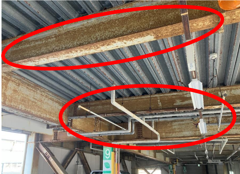
錆の浸食等による柱・梁 の塗装面の劣化
