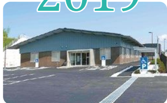
津南防災コミュニティセンター
