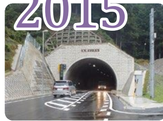
県道一志美杉線矢頭トンネル
