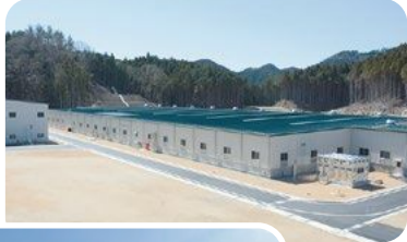
一般廃棄物最終処分場
