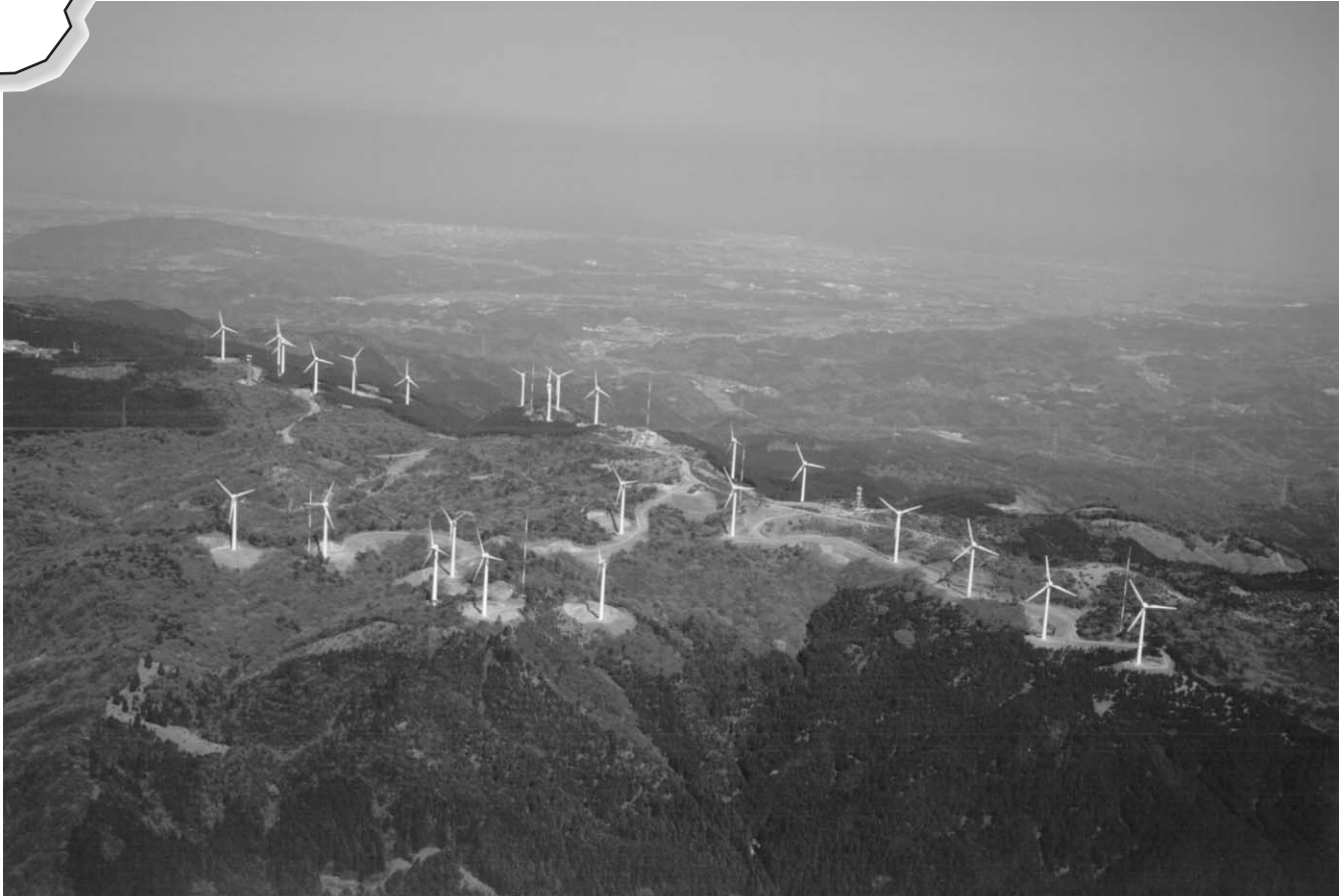
久居榊原風力発電施設（久居市榊原町）
