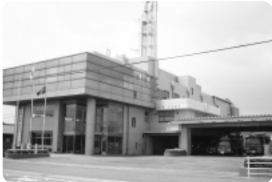
新市の消防本部庁舎
