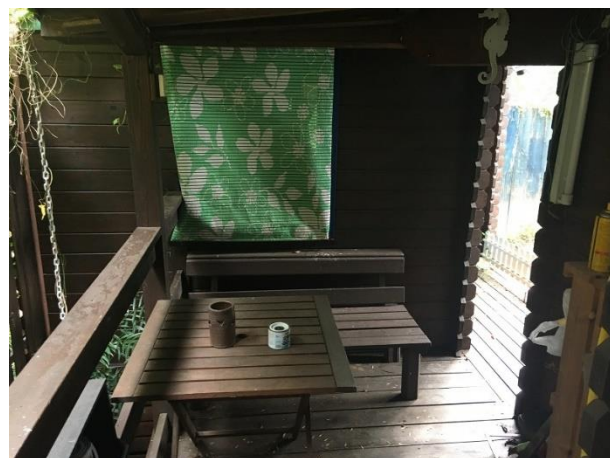
ウッドデッキ
