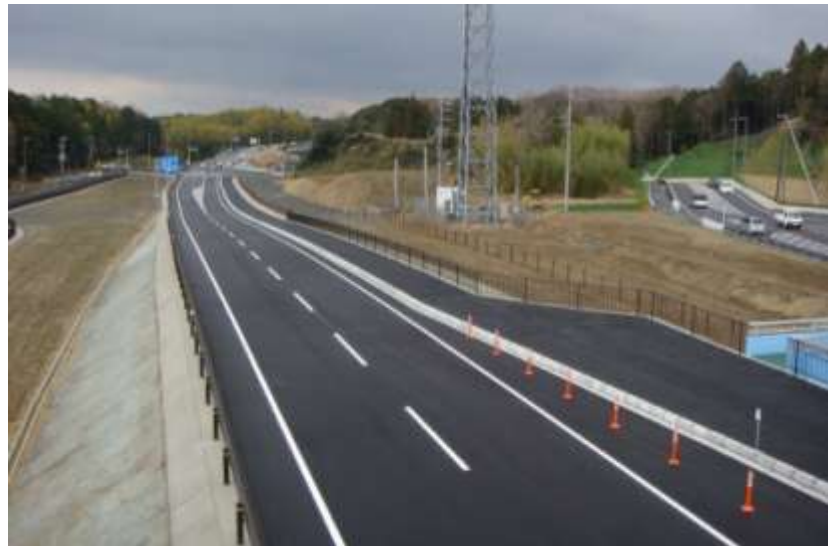
津(河芸)工区完成【平成24年3月】
