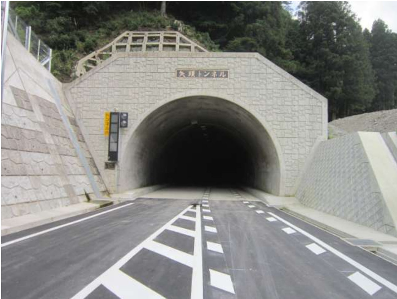
開通した矢頭トンネル(美杉側坑口)
