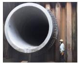
を開始し、藤方第2雨水幹線でも、内径3.4mの巨大管渠を1.5kmにわたって敷設するための立坑の建設に着手します。令和8年度までに雨水管渠とポンプ設置工事を完了し、浸水のないまちを目指します。
