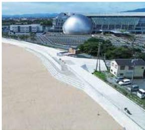
津市市街地と企業や交通施設、病院などを津波・高潮の浸水から防護するために、国は堤防の老朽化対策だけでなく、南海トラフ地震発生に備えた耐震化も施す抜本的な改良を行っています。
