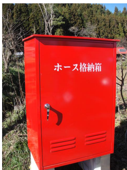
消火栓ボックス
