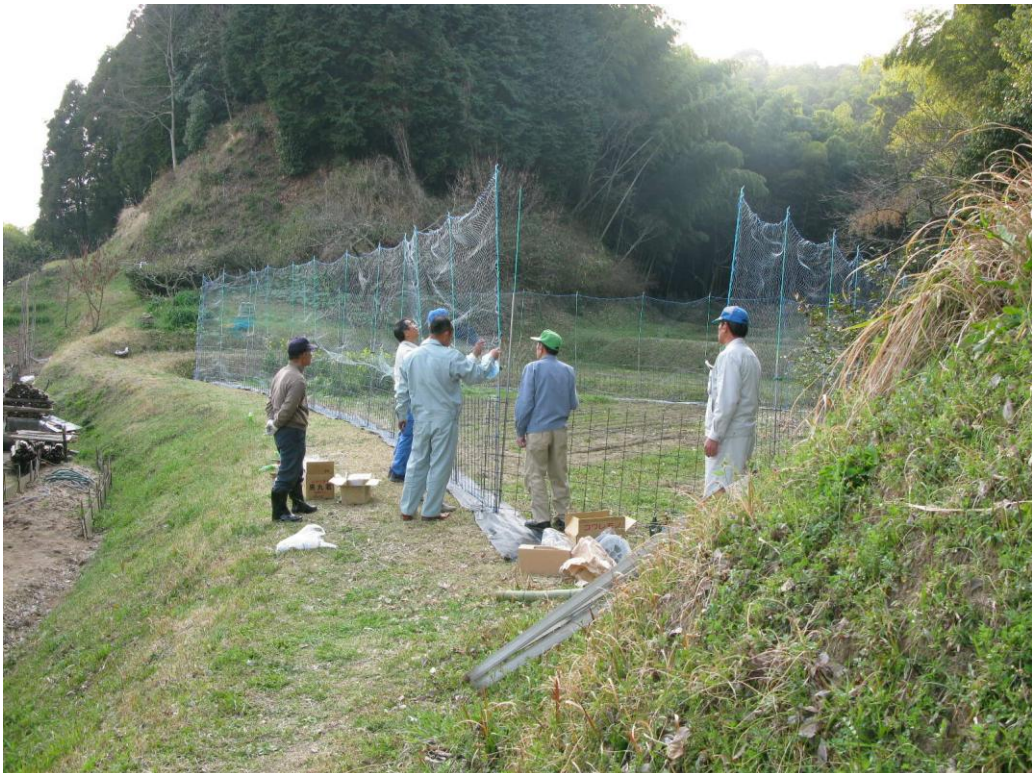
片田地区獣害対策協議会の防護柵設置の様子
