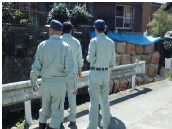
《岩田川洗掘現場（津市片田久保町）》
