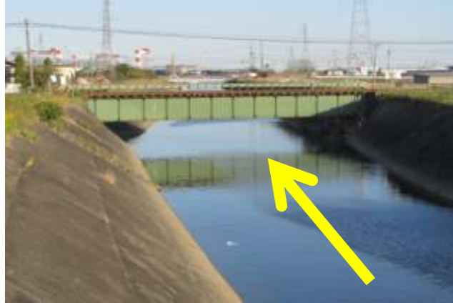
流下能力不足や事業進捗に ネックとなる橋梁
