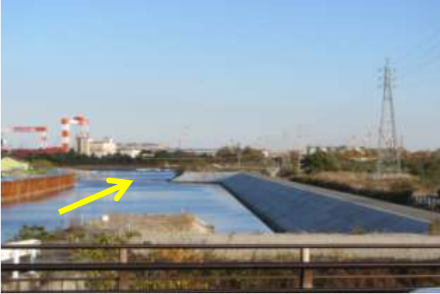
引堤により完成した 河口部(右岸)
