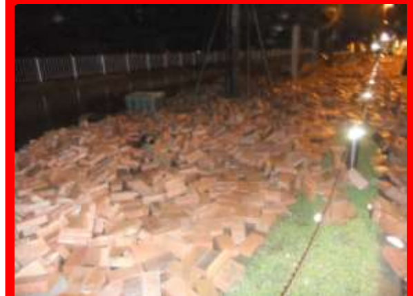
護岸被害 (19:30頃撮影)
