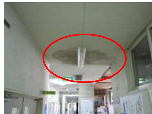
天井部分の 水漏れ
