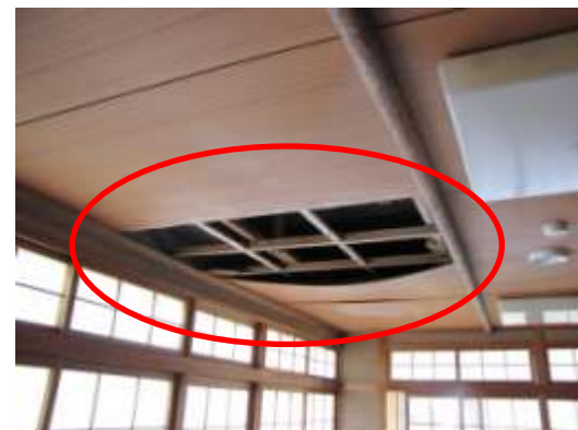
天井部分の 水漏れ損壊
