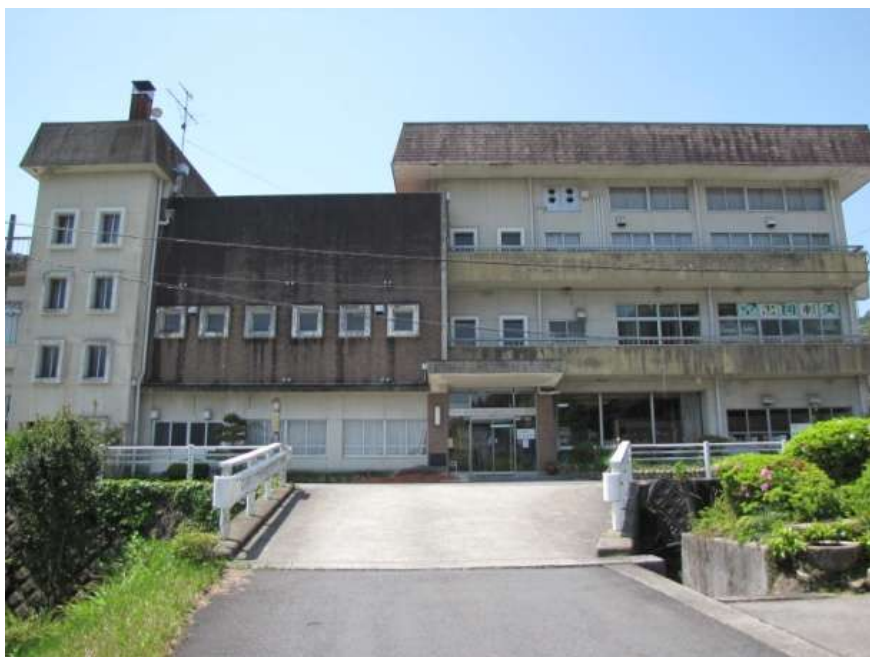
美杉総合開発センター (昭和47年建設)
