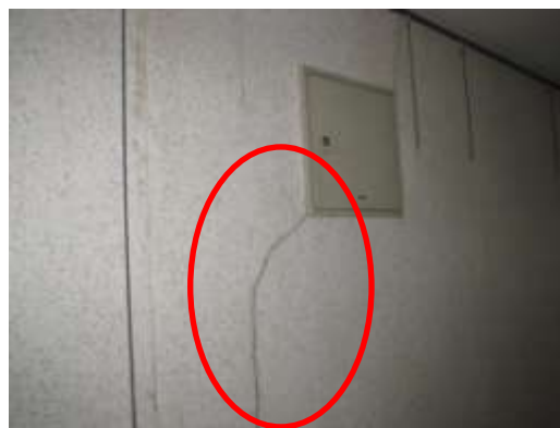
内壁部分の ひび割れ
