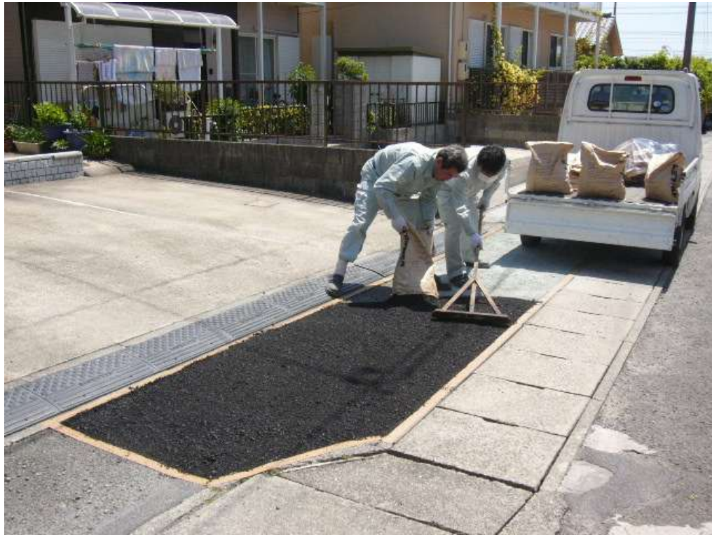
地域の道路維持・補修
