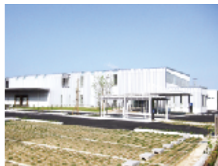
昨年9月に供用開始した津市中央学校給食センター
