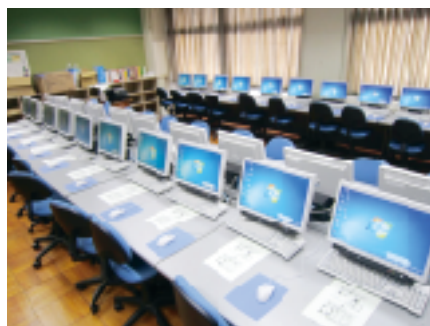
エアコンの設置を進めるパソコン教室
