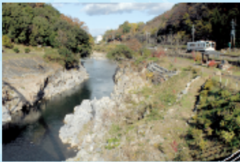
為綱が工事を行うまでは、水路が狭く、たびたび氾濫を起こしていた瀬戸ヶ淵
