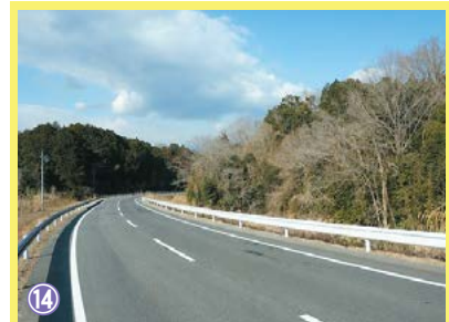
井生波瀬線道路新設改良
