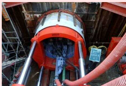
※雨水幹線の推進工事
