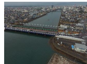
【架け替えを行う津興橋】
