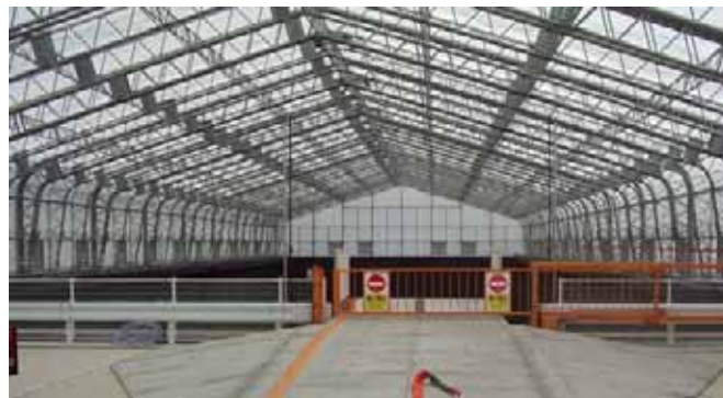
写真 2.3-2 被覆設備の例（平面トラス構造：「賀茂環境センター（東広島市）」）
