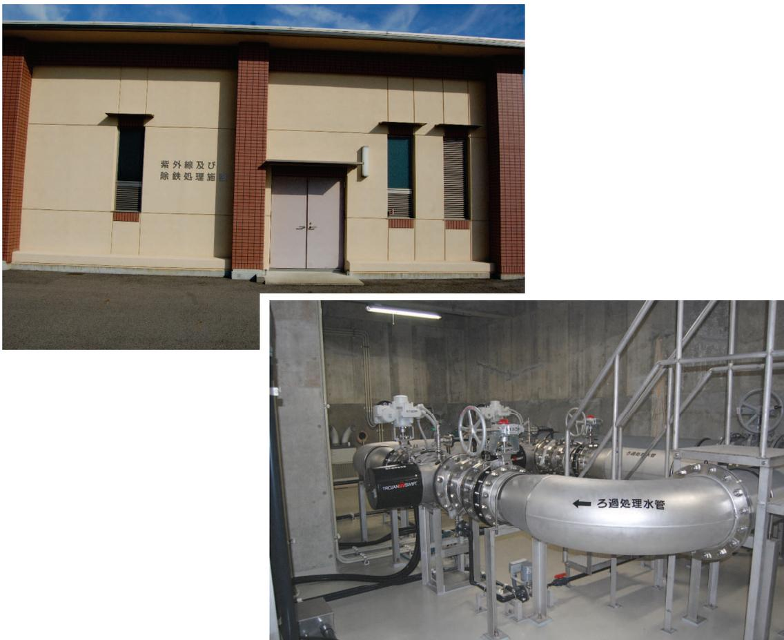
図 5.8 紫外線処理設備（高茶屋浄水場）
