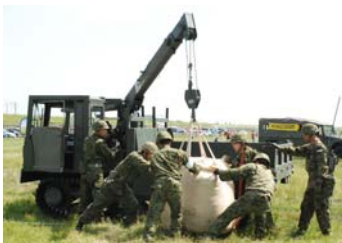
↑ 大型土のう工法を作る陸上自衛隊員
