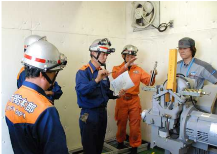
エレベーター救助研修会で巻き上げ機の仕組みの説明を受ける署員(5/24消防本部にて)
