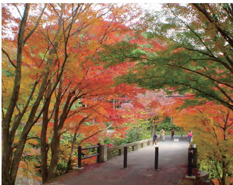
年に架けられた延長約18m、幅4mのコンクリート造りの橋です。建設時には、橋を支える支保工をまず組み、型枠を設けてコンクリートを流す工法が取られましたが、当時はコンクリートも手練りでその量も半端なものではなく、かなりの重労働であったと思われます。安濃川上流には、このような橋がいくつも架けられ、林業が中心であったこの地では、多くの人々や物資が行き交いました。しかし、林業の衰退と安濃ダムの建設により周辺の環境は大きく変化し、その当時に架けられた橋も災害やダム建設により水没するなど、現在ではこの忍田橋が残るのみです。昭和50年に津芸濃大山田線の整備に伴い瀬野橋が架けられるまでは、地域の動線としてなくてはならない
