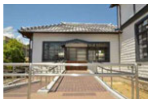
旧来賓室棟(南面)
