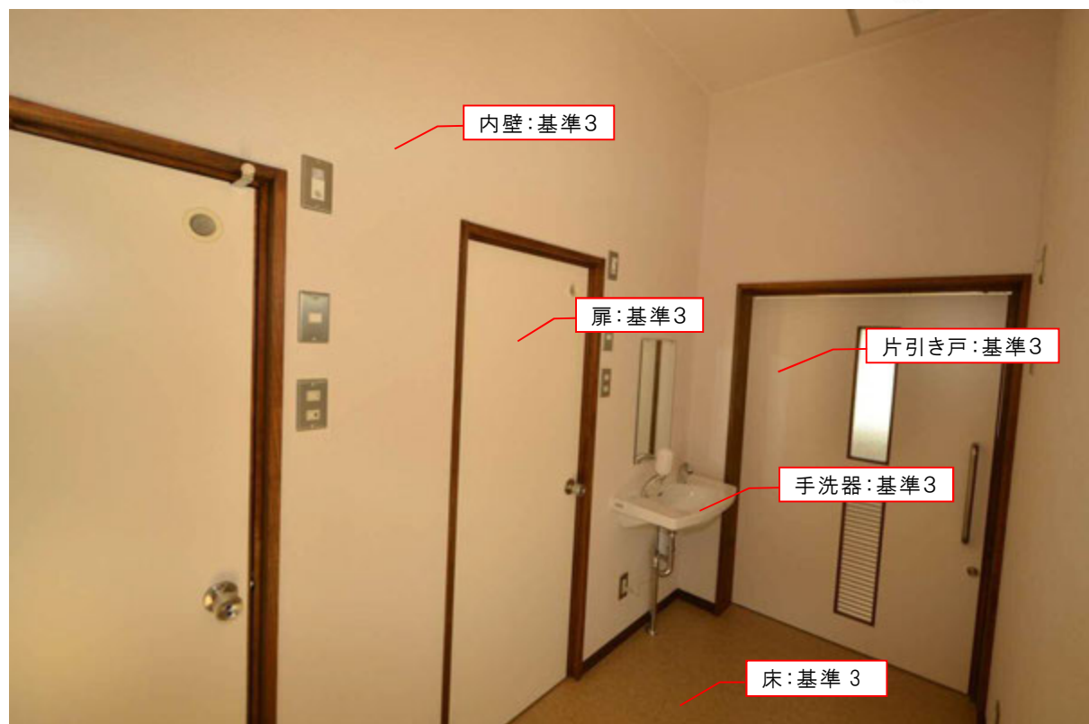
東廊下（北東面）
