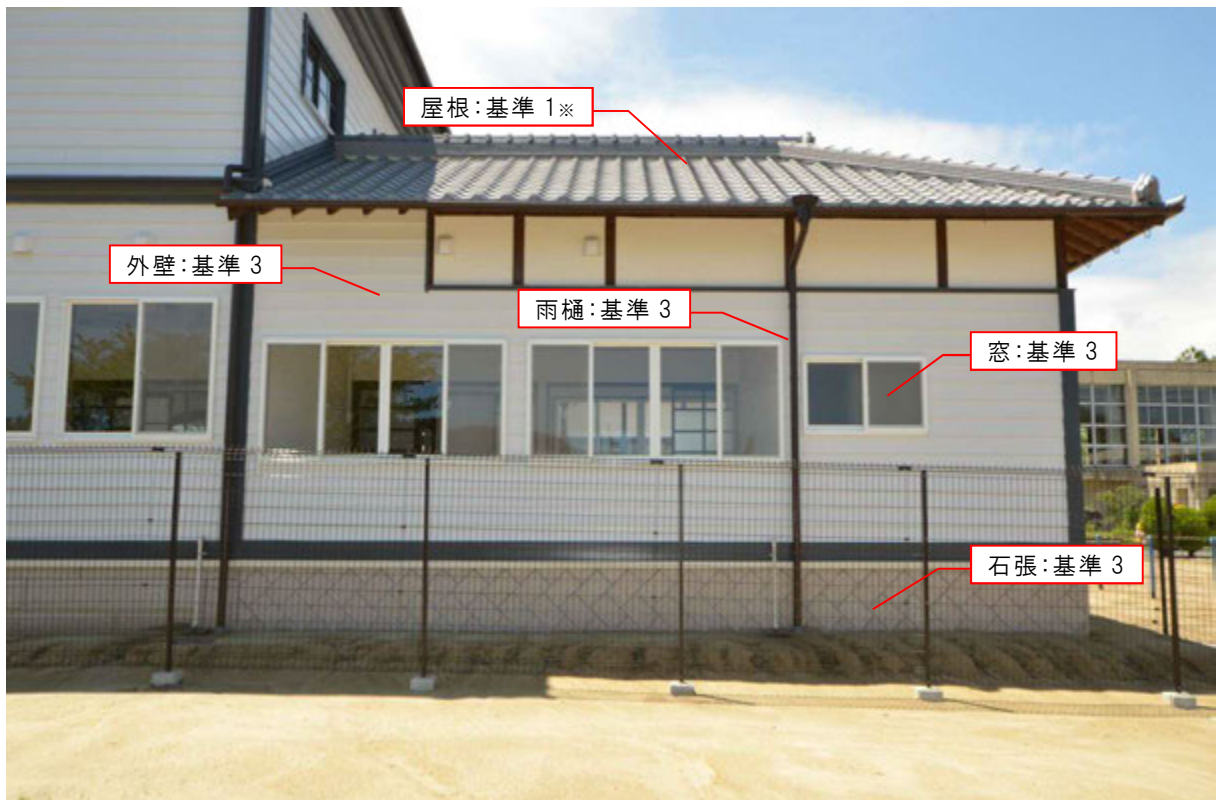
旧小使室棟(西面)
