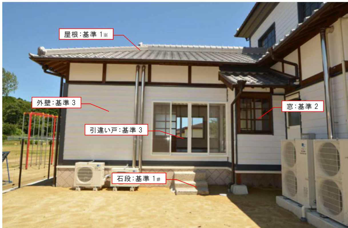
旧小使室棟（東面）
