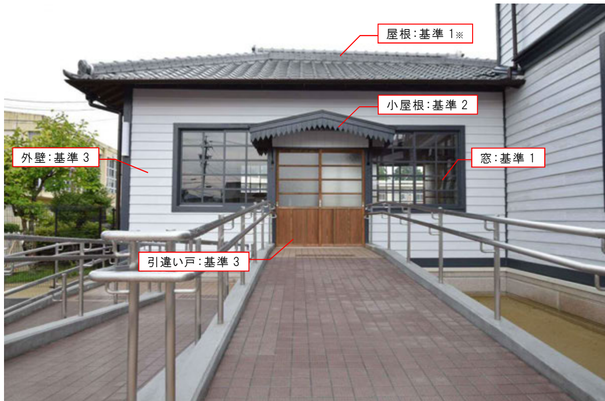
旧来賓室棟 (南面)
