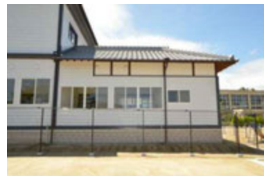
旧小使室棟（東面）
