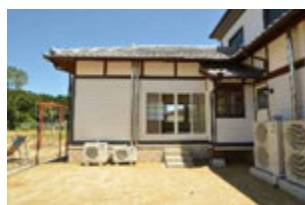
旧小使室棟（西面）
