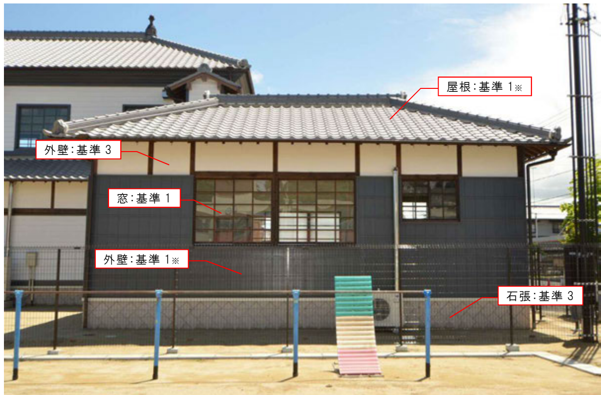
旧来賓室棟（北面）
