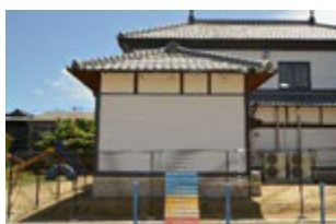
旧小使室棟（北面）
