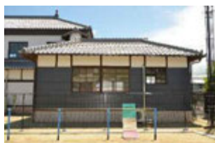
旧来賓室棟(北面)
