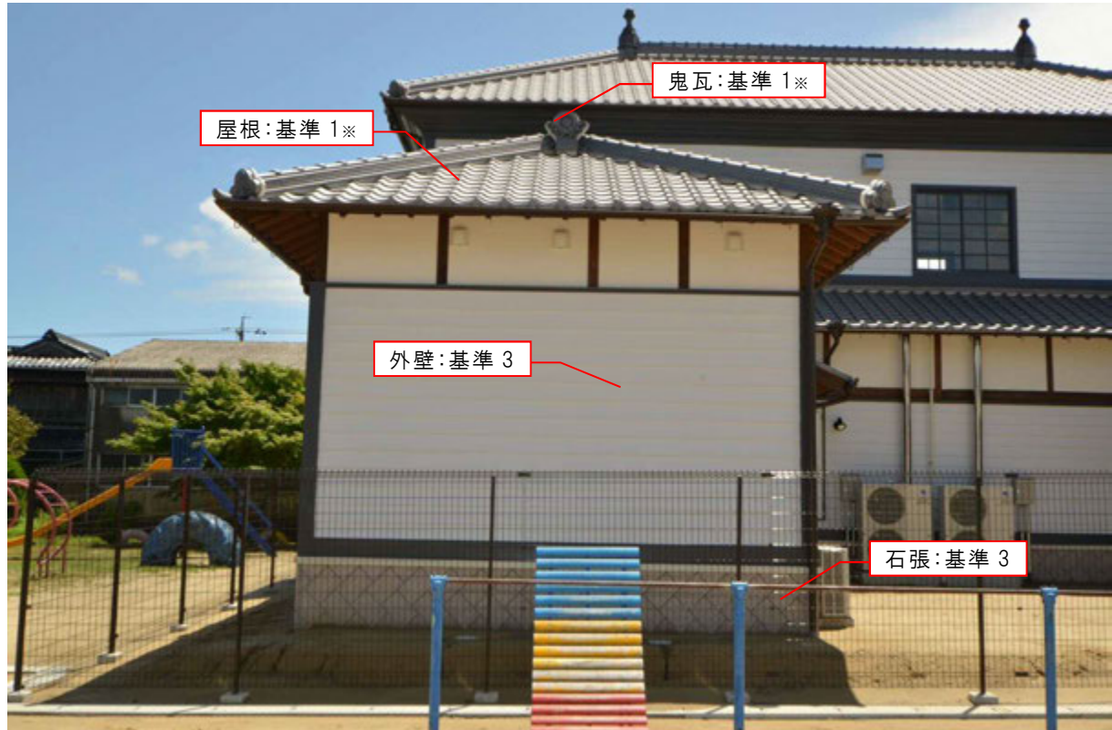
旧小使室棟（北面）
