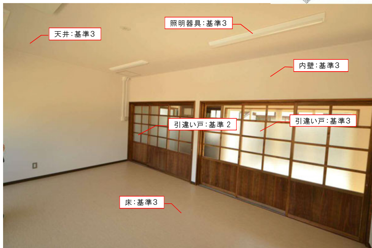
憩いの部屋 2（南西面）
