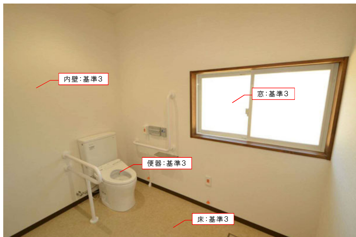
多目的トイレ(北東面)
