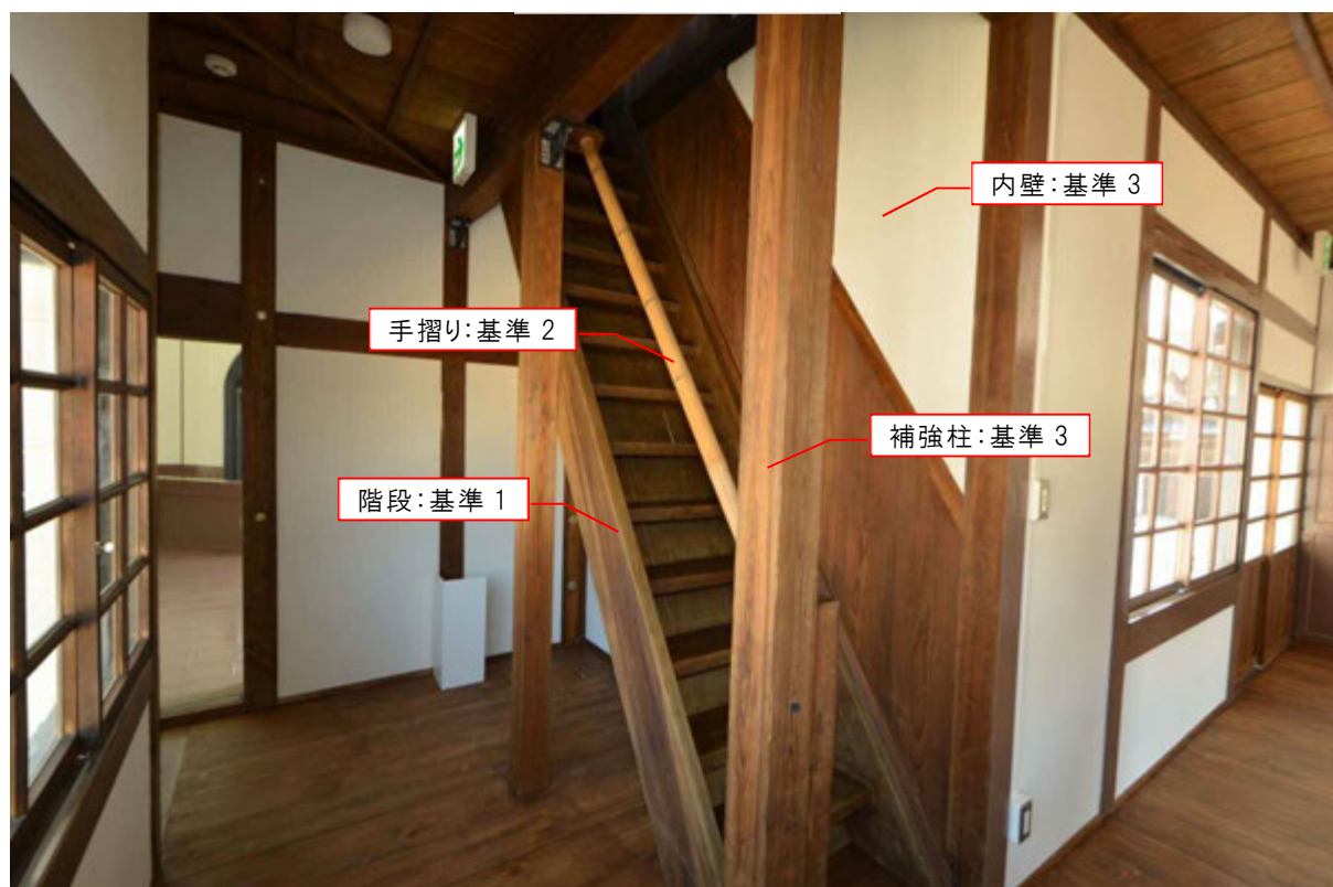
西階段（南西面）
