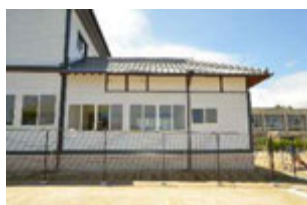
旧小使室棟（東面）
