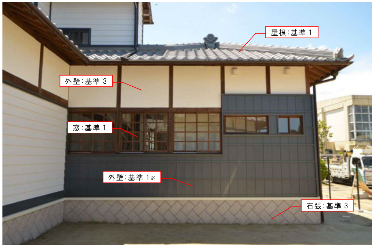
旧来賓室棟（東面）
