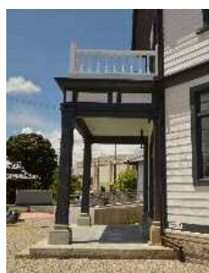
昇降口(南東面)
