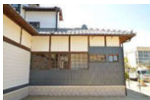
旧来賓室棟(東面)
