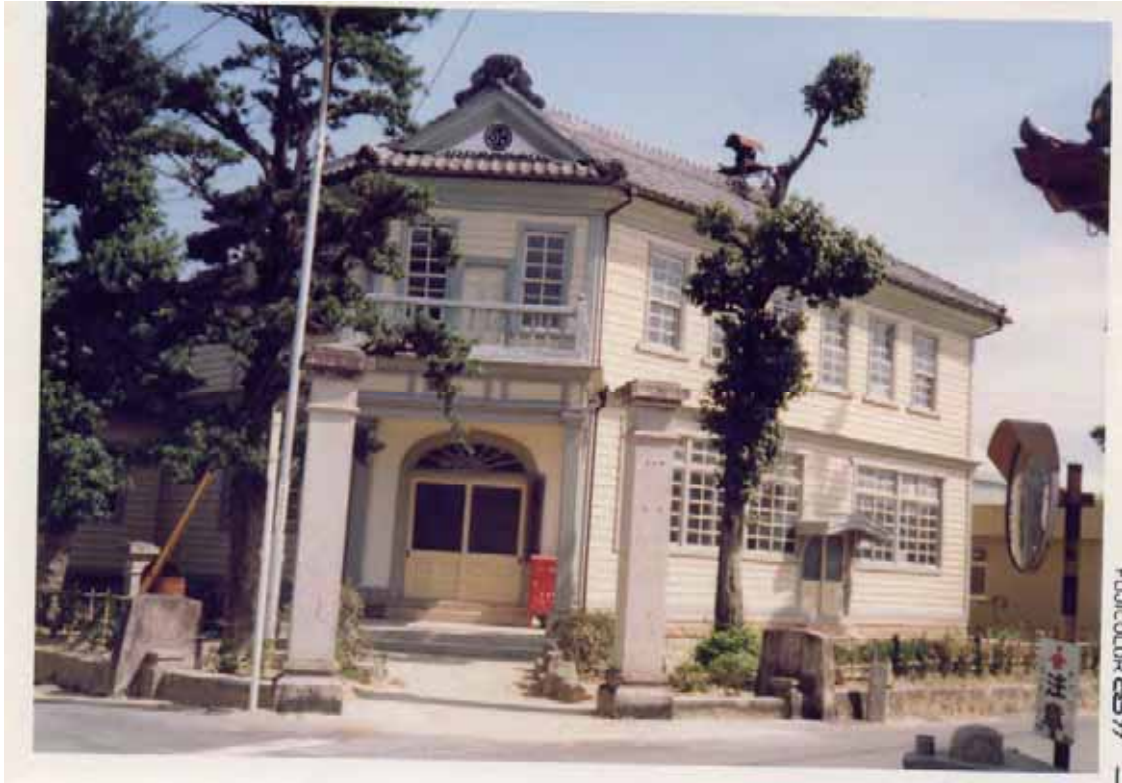
昭和 52 年頃の写真（右縁の 77 は 1977 年現像を示す）。外構の南辺・西辺の植栽は低く支持柱が見られ、外壁の塗装も真新しい。大棟東端にサイレンが残る。
