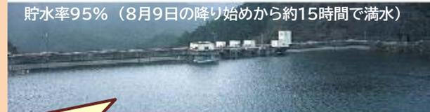
この時、安濃ダムでは746万m<sup>3</sup>(およそ東京ドーム6個分)の雨水をダムに貯め込むことで、安濃川の水位が最高に達した時点でも下流への放流量を最小限に抑えることができました。
