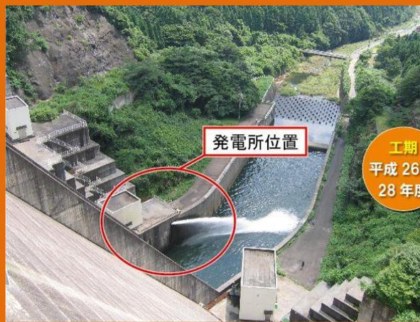
安濃ダムでは、ダム直下に河川放流水を活用した小水力発電施設が完成し、平成28年4月、再生可能エネルギー固定価格買い取り制度による売電を開始。
