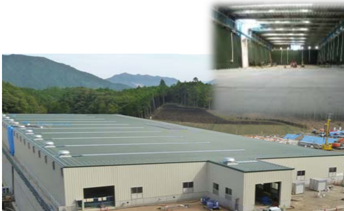
一般廃棄物最終処分場の整備 (平成28年4月1日供用開始)
