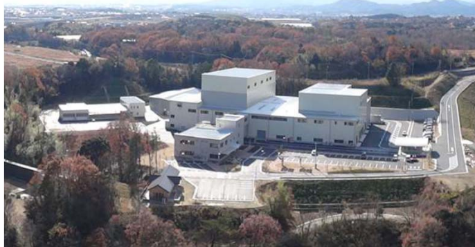
リサイクルセンターの整備 (平成28年4月1日供用開始)
