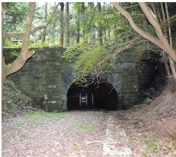
旧長野隧道(津市側) ※内部へは入れません。
