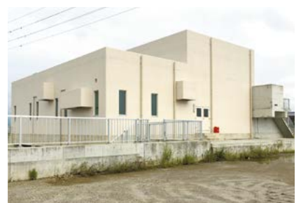
平成27年度実施工事 「半田川田ポンプ場(上屋建築)築造工事」
