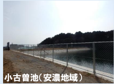
ため池(耐震改修)
