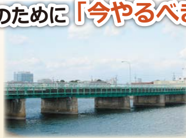
▶ 架け替えを行う津興橋
