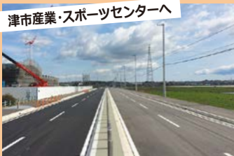
▶ 北河路橋安東小学校線
