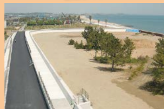
▶ 津松阪港海岸(栗真町屋工区)
