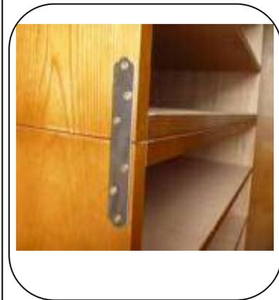
積み重ね家具については、上下を連結金具で固定した上で、L字金具と皿木ネジで柱など構造的に強い部分に固定する。
