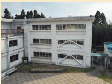
▶ 耐震化された校舎
