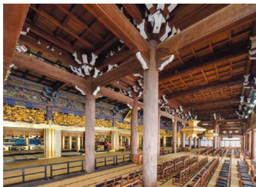
天井までの高さは約8m。通し柱の数を減らして作られた広い空間では、一度に約2,000人が参拝できる。内陣の金色に輝く柱と多彩な天井画が尊厳な雰囲気醸し出す
