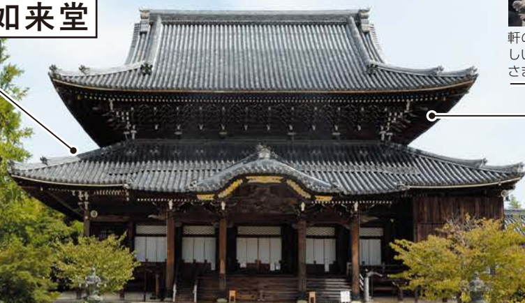
柱の間隔を広く取り、天井の高さを変えることで堂内を広く感じさせている。内陣は柱と壁、欄間に至るまで金箔をはり、壮麗な空間を作り出している
