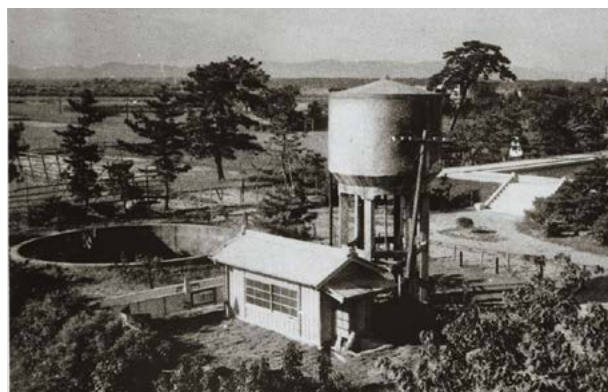
建設当初の給水井戸(左端)と給水塔／三重大学提供
