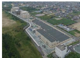
志登茂川浄化センター
