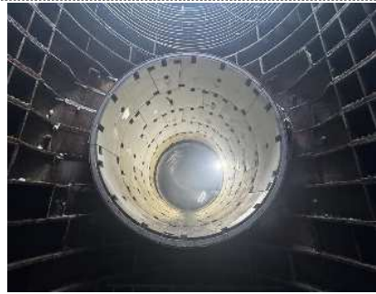
到達立坑から見たφ3400の管内 藤方第 2 雨水幹線築造工事
