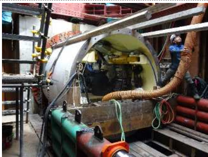
第 2 雨水幹線φ2000の施工状況 半田川田第 2 雨水幹線築造工事
