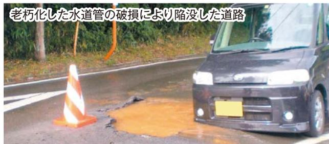
老朽化した水道管の破損により陥没した道路
