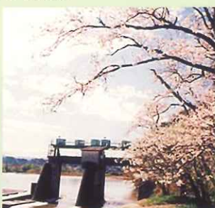
(雲出井取水口)
