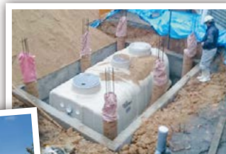
市営浄化槽設置の様子
