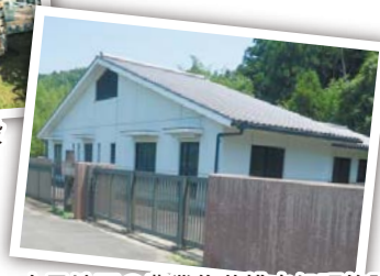
大里地区の農業集落排水処理施設
