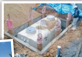
市営浄化槽設置の様子
