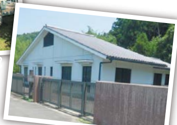
大里地区の農業集落排水処理施設
