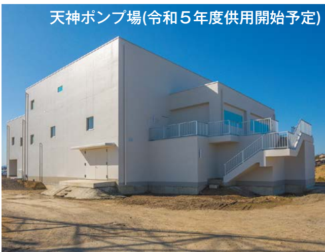
令和2年3月(上屋建築完了)
