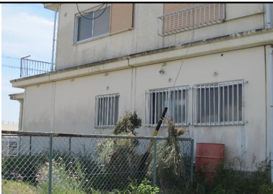
7 占有物（支線）の状況
