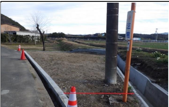
1 占有物（電柱）の状況
