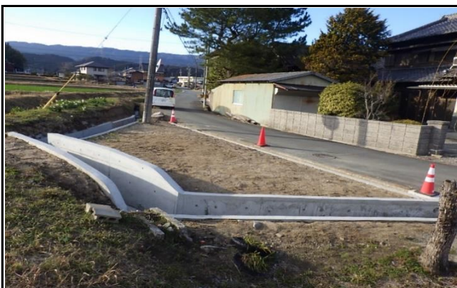
3 物件南東部から北西を望む
