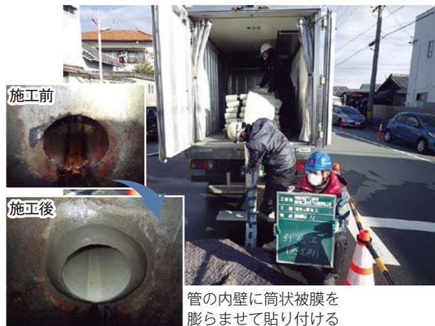
老朽化した汚水管の修理や耐震化をする時は、内側を特殊な加工で改築する管更生工法を採用しています。道路を掘り返さず工事できるため、安価で短期間の施工が可能です。
