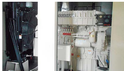
浄水場への非常用発電設備の設置
