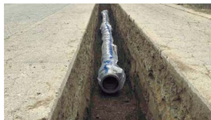
老朽管の更新工事
