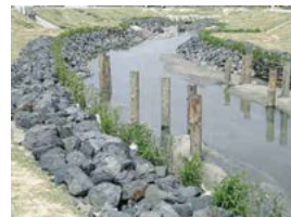
護岸工事の石材にリサイクルされた灰
